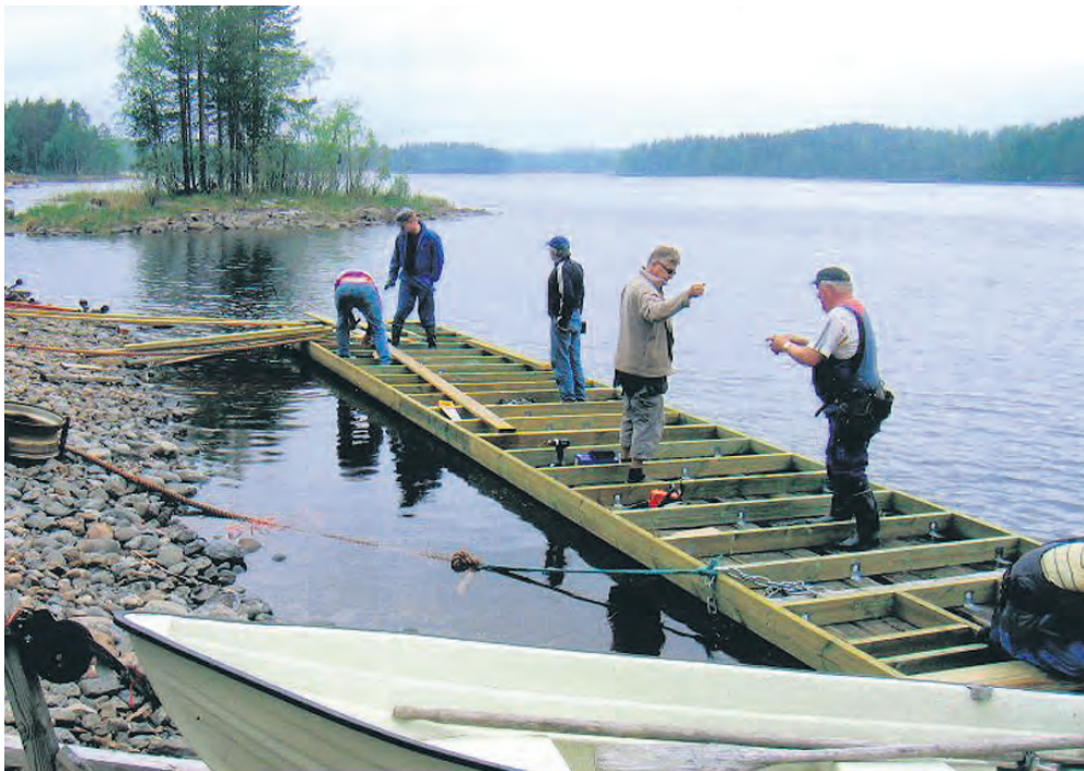
Talkoolaisia laiturin rakennuspuuhissa vuonna 2012.
