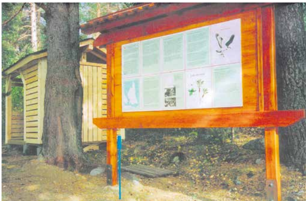
Opastetaulu, halkoliiteri ja roskakatos Suursaaren retkisatamassa rakennettiin v. 2006.
