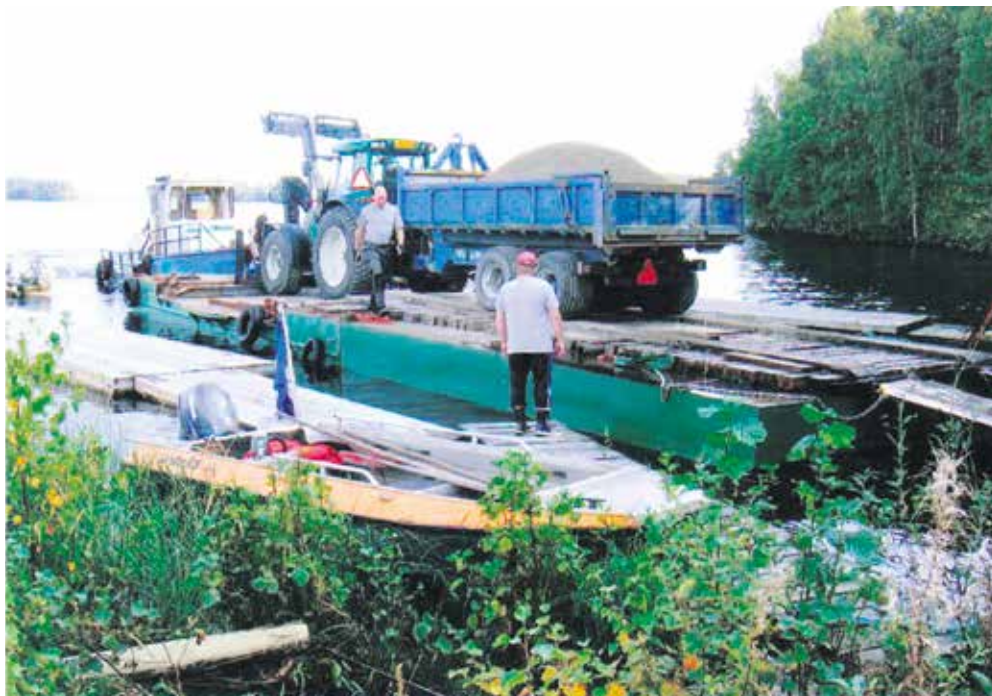
Rakennustyöt Tikankaivannossa: A. Sahlmanin lautta- ja hinauskalusto tuomassa so- raa.
