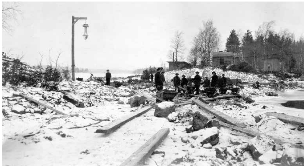
Tikankaivannon kanavatyömaa 1915. Kuva H. Nilsen
