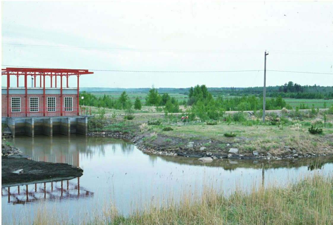
Kuivatusalueen poistoveden pumppaamo valmistui vuonna 1967. Kuva: Rääkkylä-Seura.
