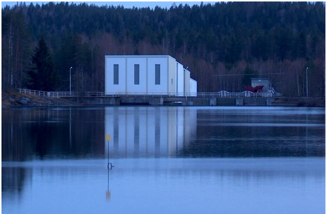
Puntarikosken voimalaitos yläkanavan suunnalta nähtynä. Kuva: Tommi Sallinen
